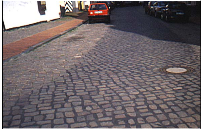
Bild 6-12: Fugenverguss von historischem Pflaster im Zuge einer Radroute (Lübeck)
