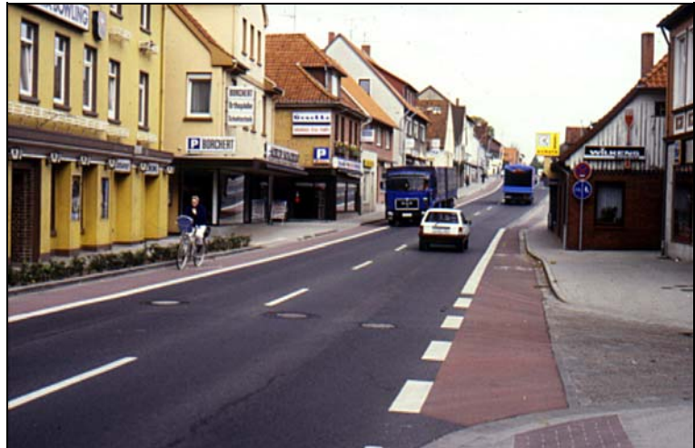
Bild 6-7: Engstelle mit schmalem Radverkehrsstreifen und eingengter Fahrbahn (Walsrode)
