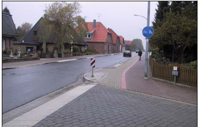
Bild 6-4: Teilaufpflasterung eines Radweges an einer Einmündung (Soltau, Bergstraße)
