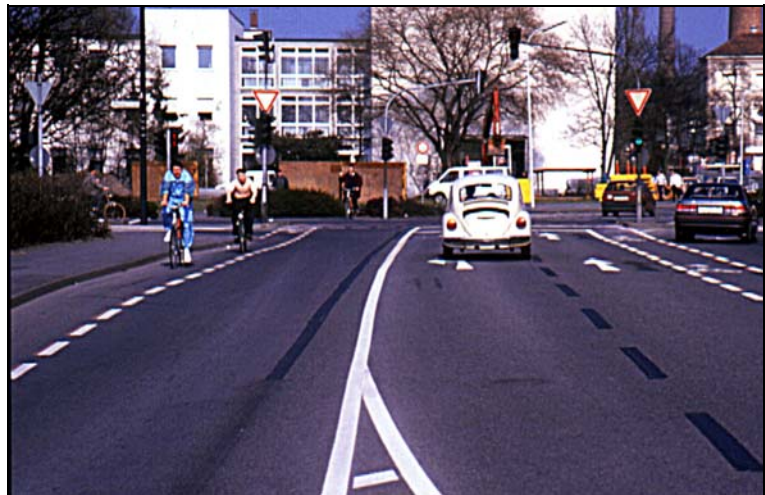
Bild 6-8: Ein überbreiter Aufstellstreifen (linksab, geradeaus) schafft die Möglichkeit zur Markierung der Radverkehrsanlagen (Troisdorf)
