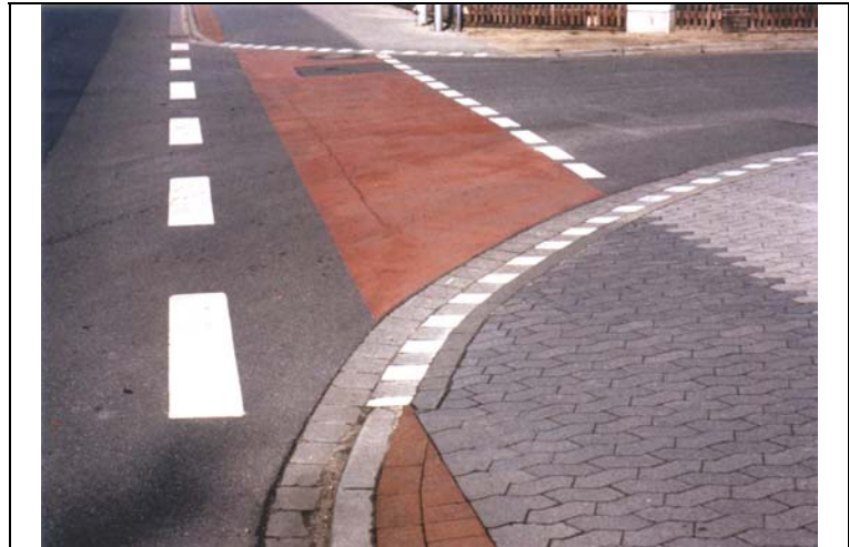
Bild 6-10: Stoßfreie Radwegabsenkung (Hermannsburg)
