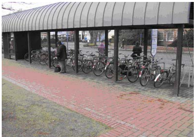
Bild 8-4: Bike+Ride-Anlage am Bahnhof Soltau
